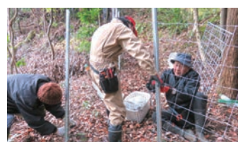
▲老若混えての組立作業
