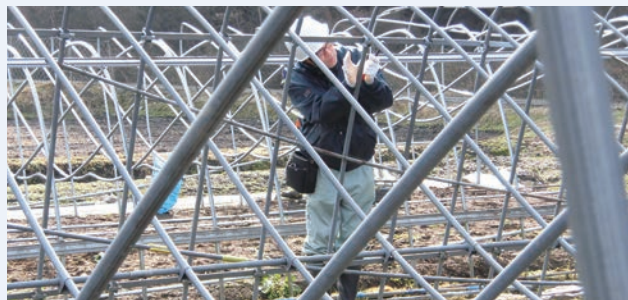
▲被害ほ場で解体作業をする職員
